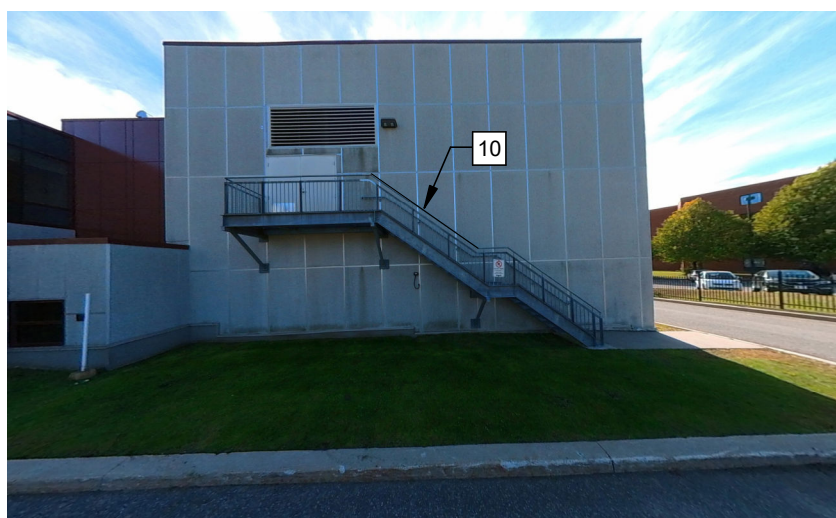
PHOTO 03 - ACCES À LA SALLE MÉCANIQUE
