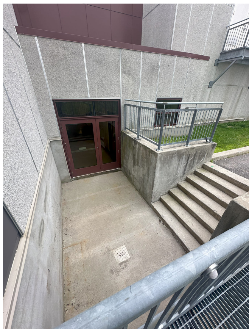
PHOTO 05 - ENTRÉE CHANTIER + LIVRAISON VARIAN
