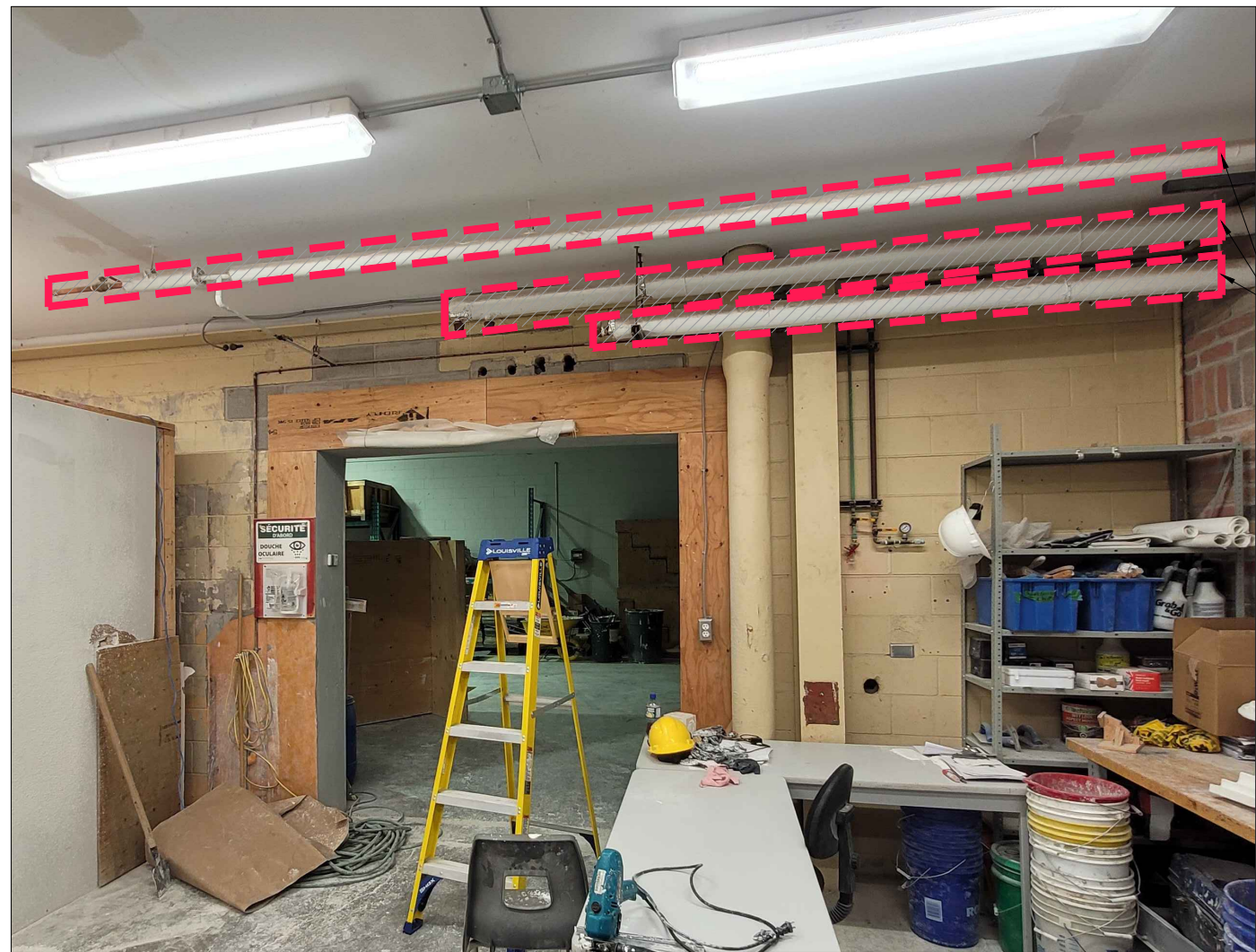
PHOTO RÉFÉRENCE #1 | PLOMBERIE | DÉMOLITION ÉCHELLE: AUCUNE
