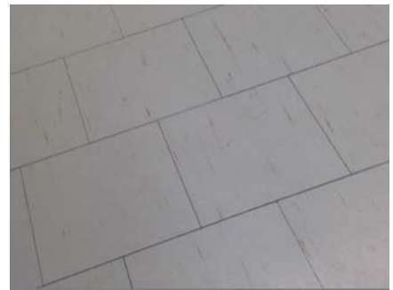
28 • TUILE VINYLE • /208 2015-01-30 19:42 - Administrateur Plancher Intact
