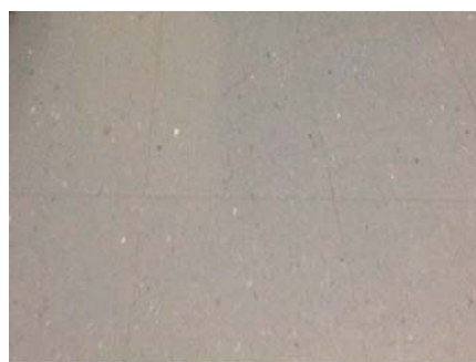
18 • TUILE VINYLE 2015-01-30 19:18 - Administrateur Plancher Intact
