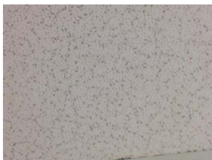
29 • TUILE ACOUSTIQUE • /101 2015-01-30 18:42 - Administrateur Plafond Intact
