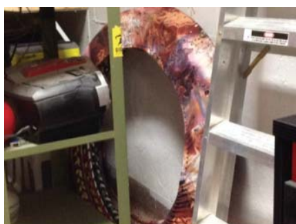
18 • CRÉPI-PLÂTRE • /110 2015-01-30 18:23 - Administrateur Mur/Plafond Moy. endommagé
