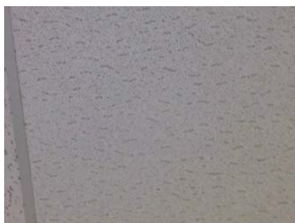
32 • TUILE ACOUSTIQUE • /100 2015-01-30 18:44 - Administrateur Plafond Intact
