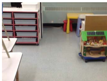
8 • TUILE VINYLE • /116 2015-01-30 17:59 - Administrateur Plancher Intact
