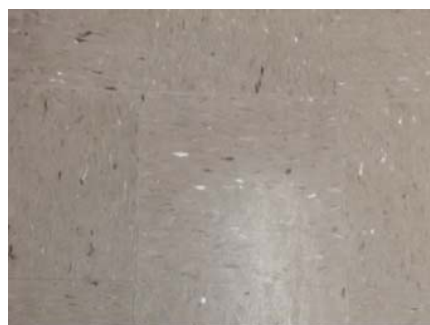
11 • TUILE VINYLE • /113 2015-01-30 18:00 - Administrateur Plancher Intact
