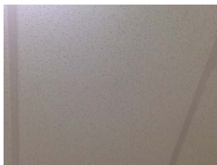
30 • TUILE ACOUSTIQUE • /100 2015-01-30 18:43 - Administrateur Plafond Intact
