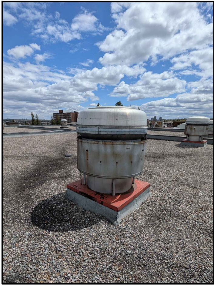
PHOTO #1 UNITÉ EN TOITURE À DÉMANTELER (VOIR PLAN M803)
