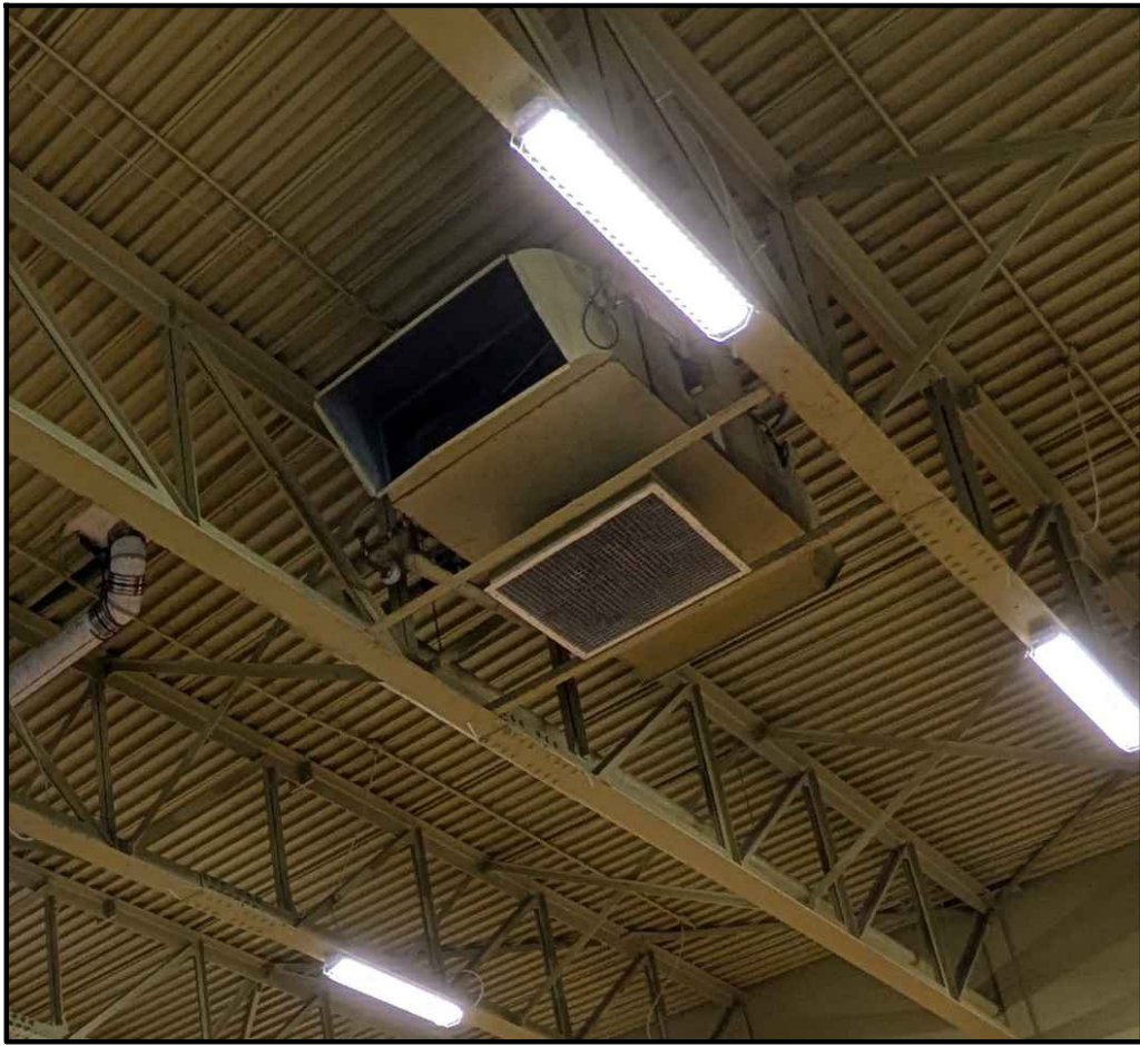
PHOTO #2 UNITÉ AU PLAFOND DES GYMNASES À DÉMANTELER (VOIR PLAN M803)
